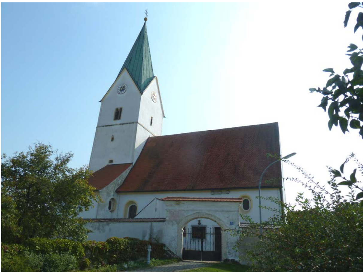
Wallfahrtskirche „Unserer Lieben Frau“ mit Friedhofsmauer von Norden
