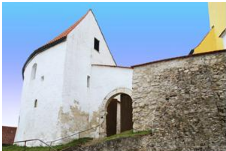
Abb. 2: Wehrhaftes Tor auf der Ostseite
