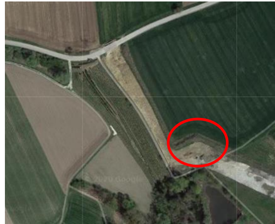
Die Leitungstrasse mit Lage der Therme (Google Maps)
