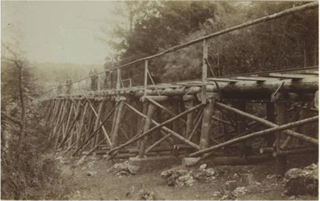
Abb. 13: Holzbrücke über den Dettenbach beim Marchinger Steinbruch
