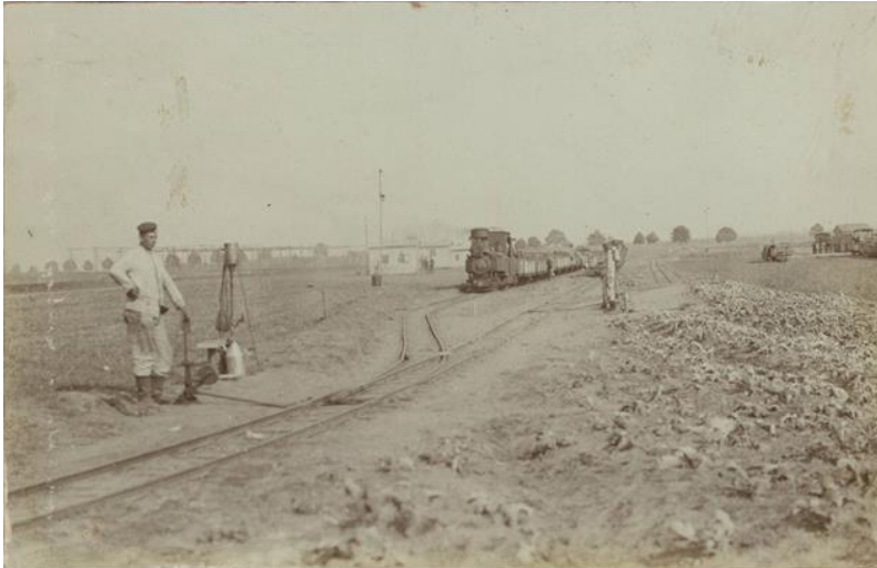
Abb. 8: Weichensteller bei der Arbeit
