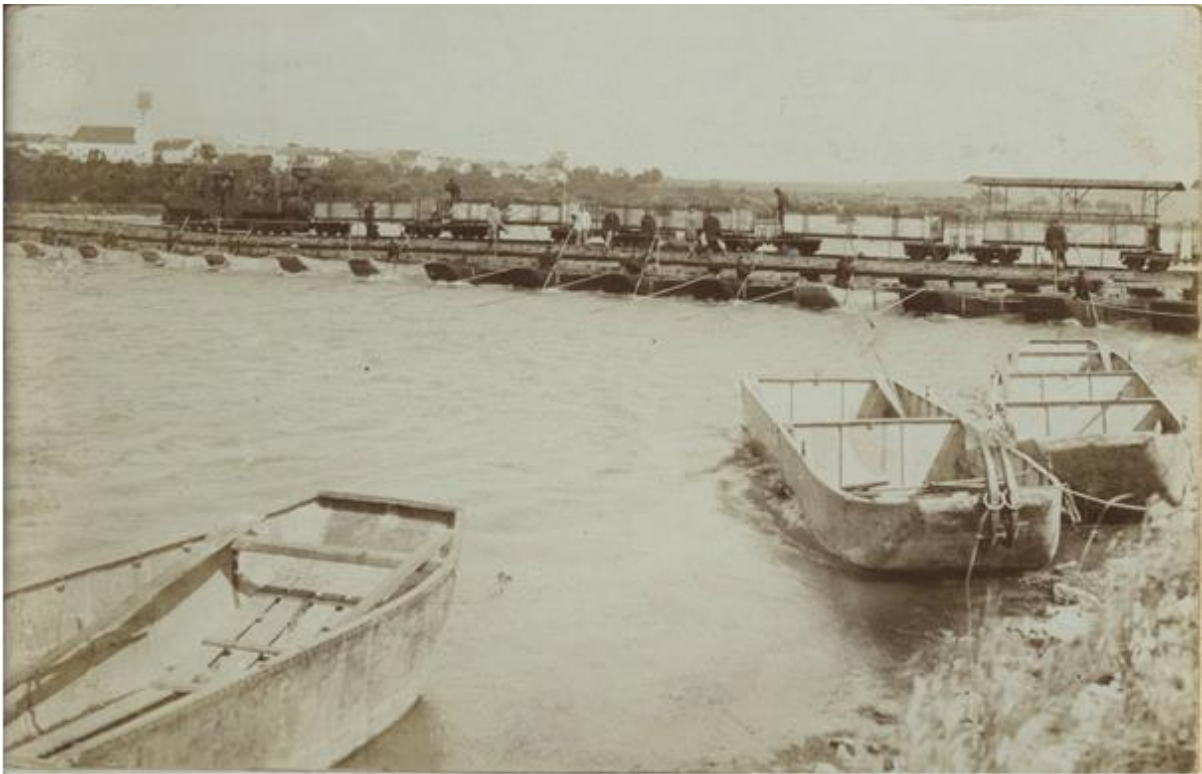
Abb. 11: Lokomotive mit Waggonen überqueren die Donau; im Hintergrund die Ortschaft Hienheim
