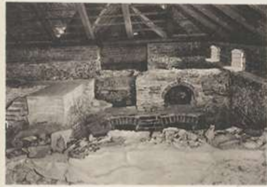
Inneres des Einzelbades. (Typische römische Badeanlage. Warmer Raum zum Auskleiden, Räume zum lauen, warmen, heißen und kalten Bad. Bodenheizung, Estrich und Steinplatten).
