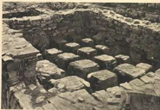
Heizpfeller mit Zementmörtelbewurf.
