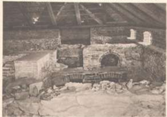
Inneres des Einzelbades. (Typische römische Badeanlage. Warmer Raum zum Auskleiden, Räume zum lauen, warmen, heißen u. kalten Bad. Bodenheizung, Estrich u. Steinplatten.)
