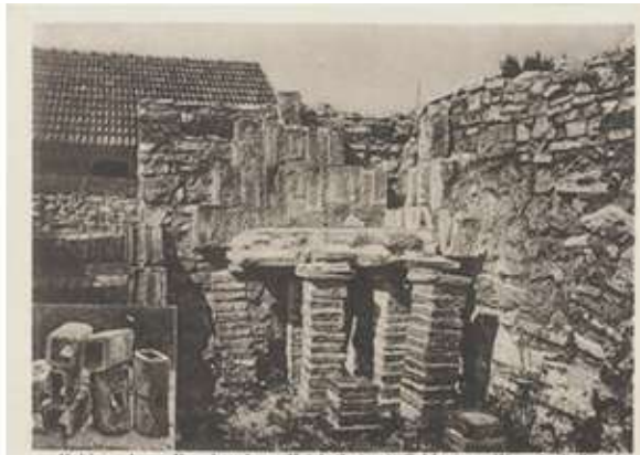
Hohlziegel. Hypocaustum (Heizkeller) mit Caldarium (Warmbad) Ziegel-Wandheizung. Pfeiler mit darüber liegendem Estrich und Wandheizung im Soldatenbad.
