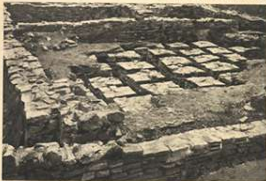
Zimmer mit Heizpfelern und Estrich auf denselben.
