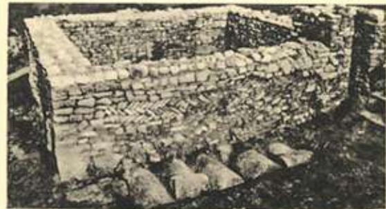
Nordosteckurm des spätrömischen Kastells. Fundament = Decksteine der Umfassungsmauer des grossen Kastells.
