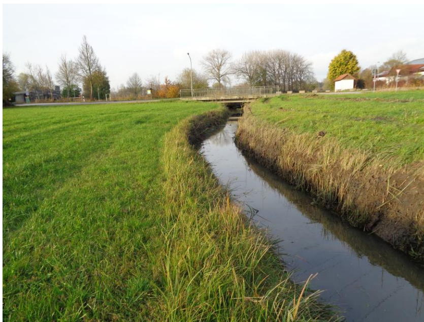
Herrnteilgraben tief eingeschnittenes Kastenprofil.
